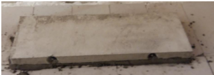
Photo de la plaque d'assise du conduit
