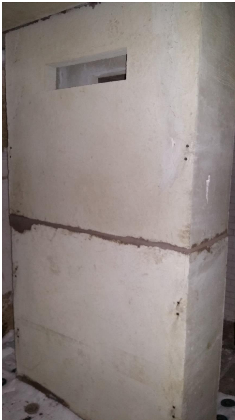
Photo de la partie du conduit exposée au feu après essai et refroidissement
