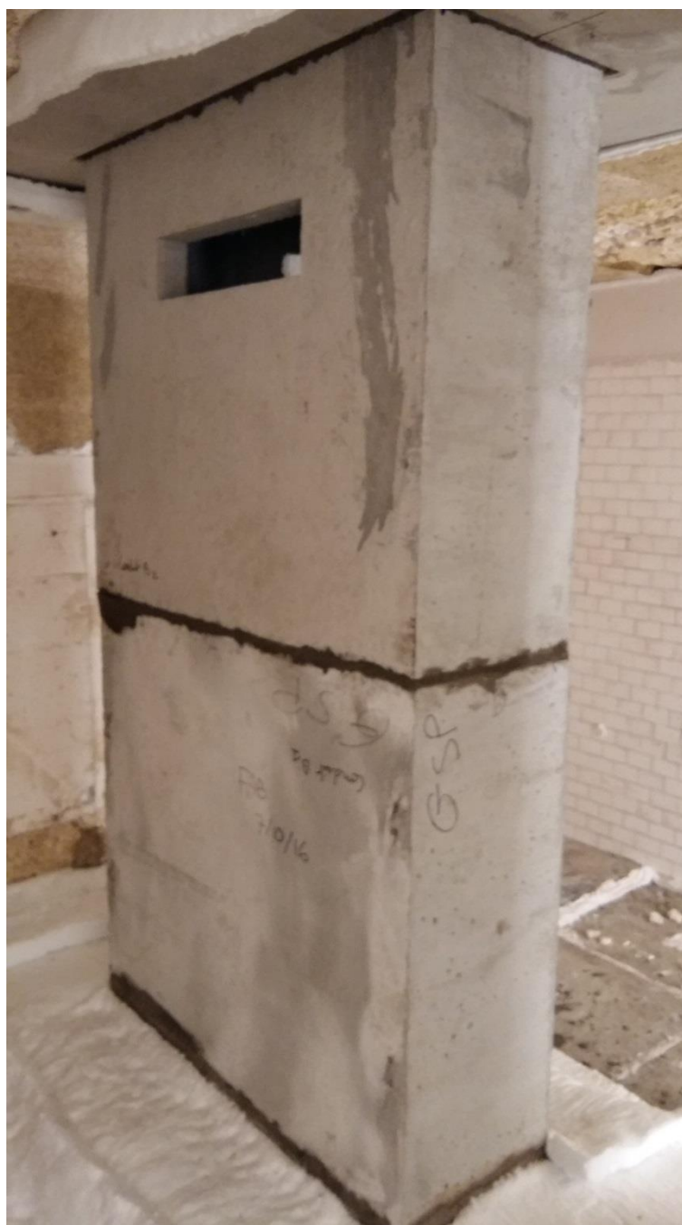
Photo du conduit monté à l'intérieur du four
