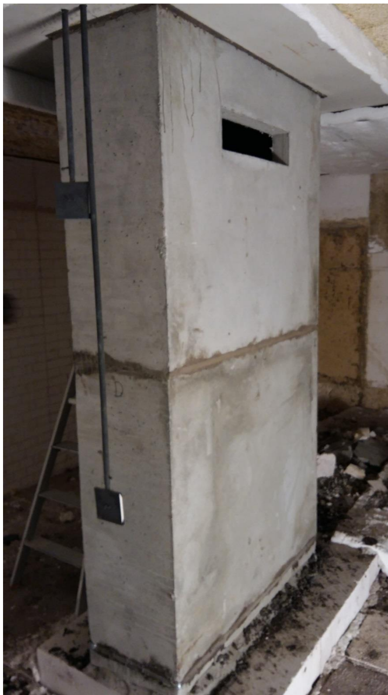
Photo de la partie du conduit exposée au feu avant essai
